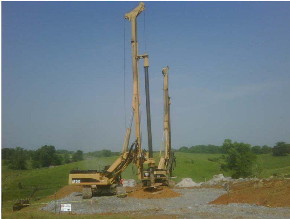
Figure 5 – IMT AF 240 Drill Rig
